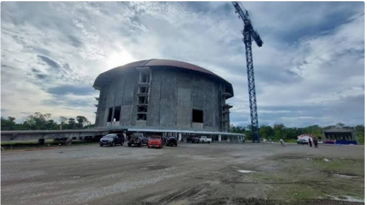
Pembangunan Gereja Kingmi Mile 32
